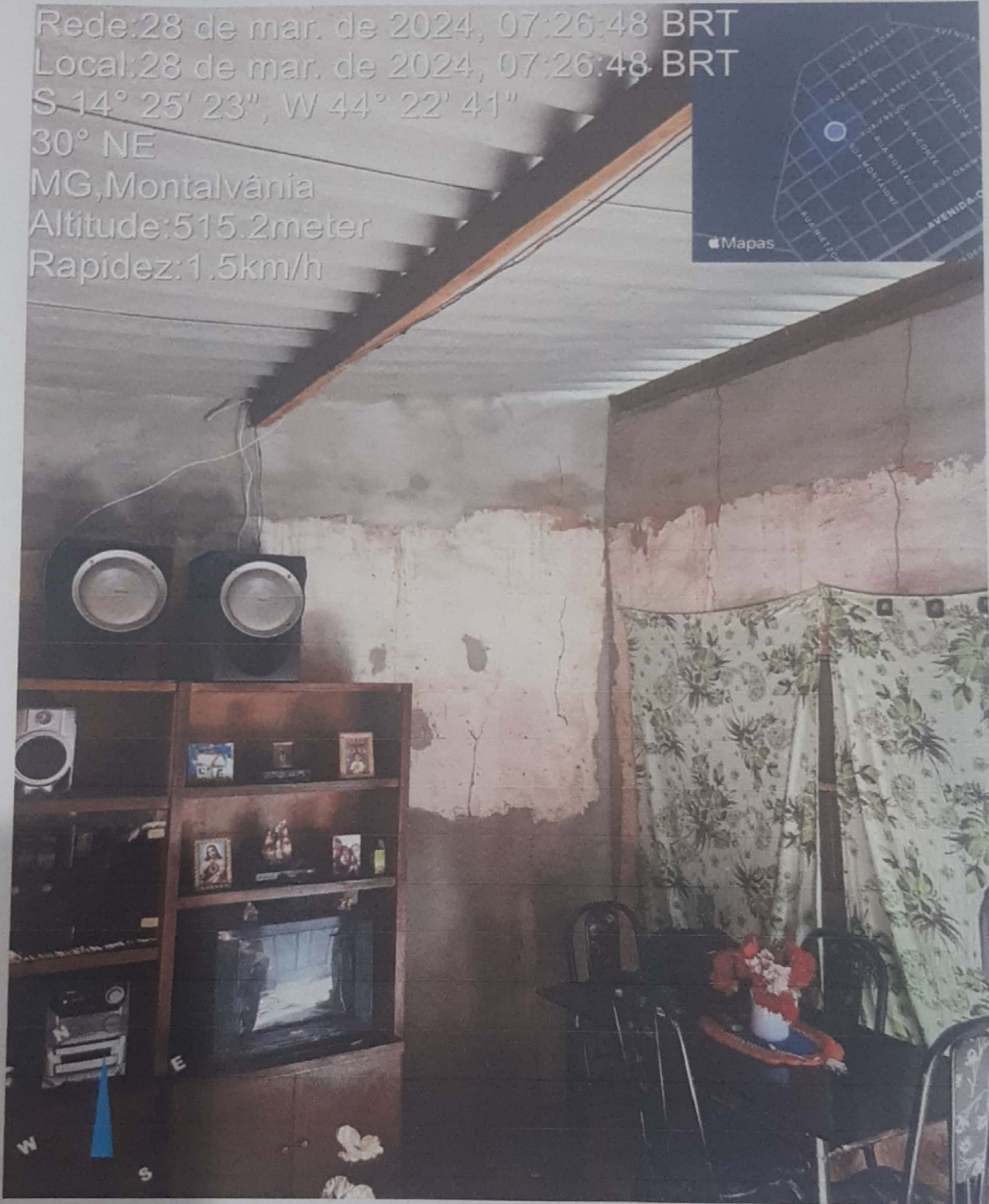
FOTO 06 – Interior do imóvel.
